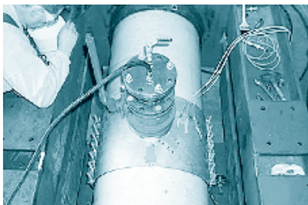
Figure 10-12 Epreuve sous pression et ensemble de vannes
