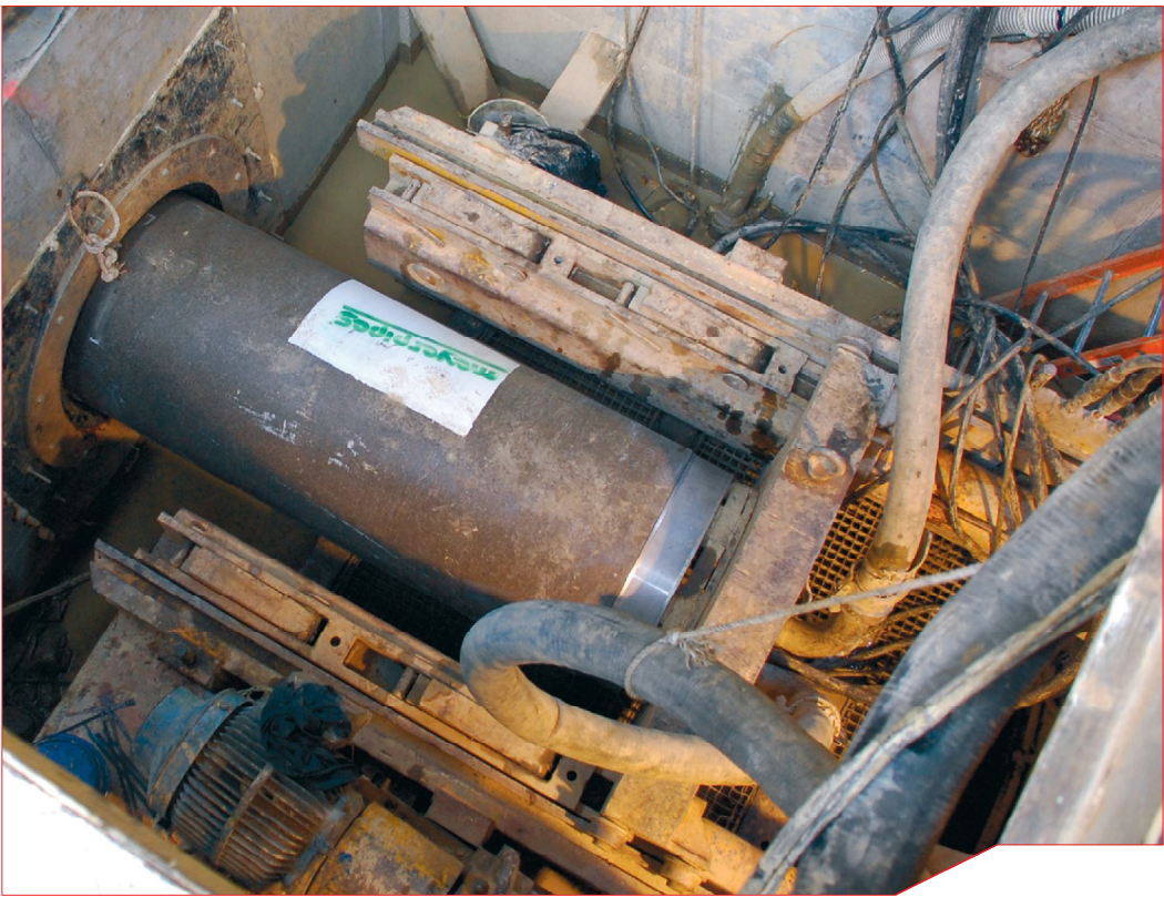
C'est un microtunnelier Herrenknecht qui permet de mettre en place les tubes en béton de résine Meyer.
